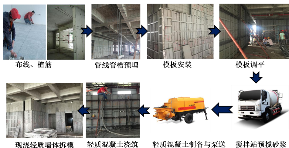
图1 轻质混凝土墙体施工流程图
