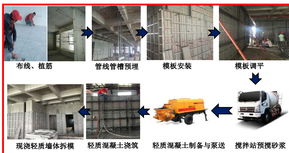
图1 轻质混凝土墙体施工流程图
